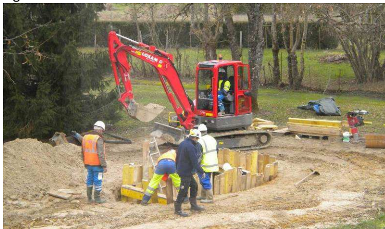
Formation « travaux réseau »
