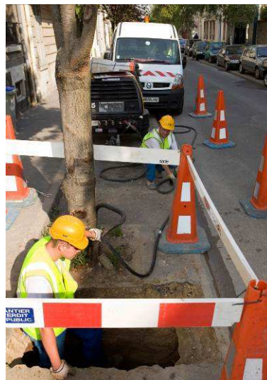
Intervention sur canalisation
